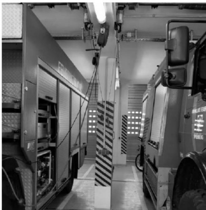
Bild 20 Als Übergangslösung: Markierung der einengenden Gebäudeteile
