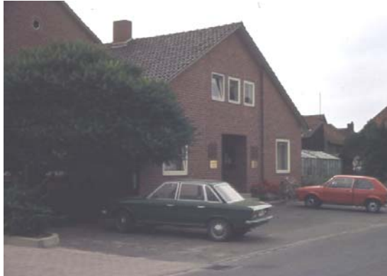
Gebäude in der Schulstraße
